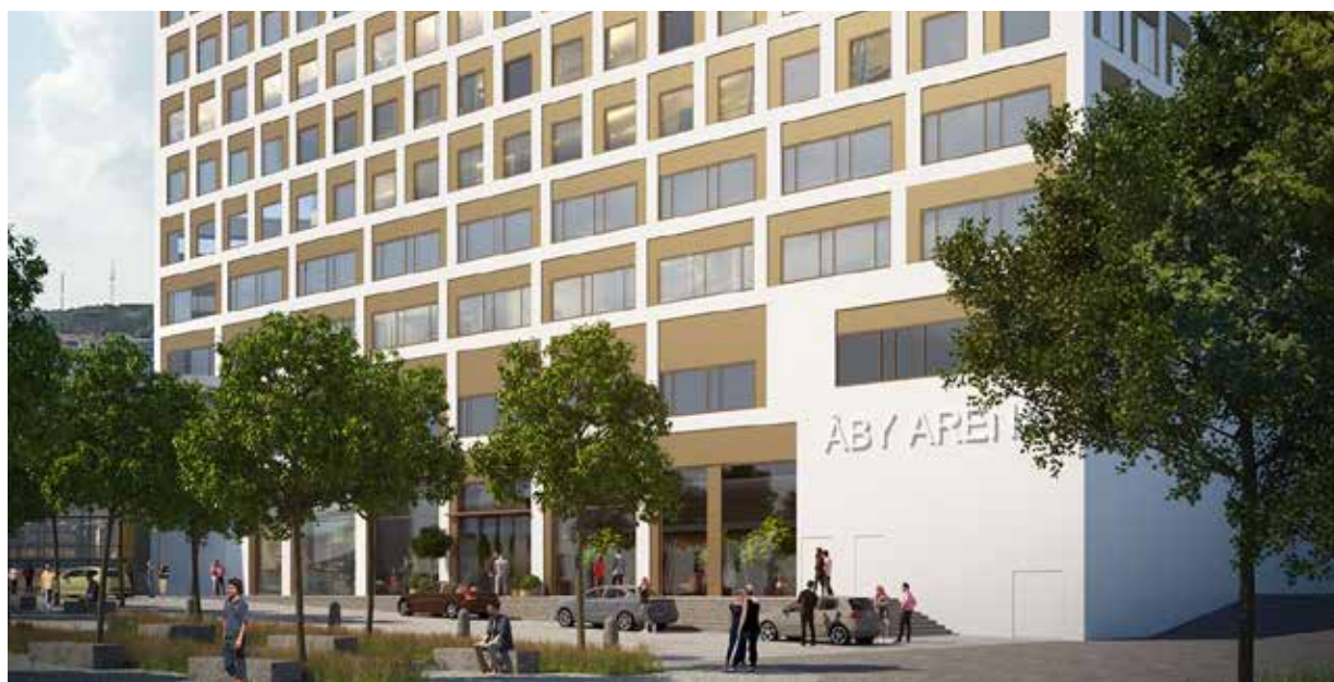
Åby Arena utvecklas av Klöverna tillsammans med Åby Travsällskap. Åby Arena kommer att certifieras enligt Miljöbyggnad Silver.
