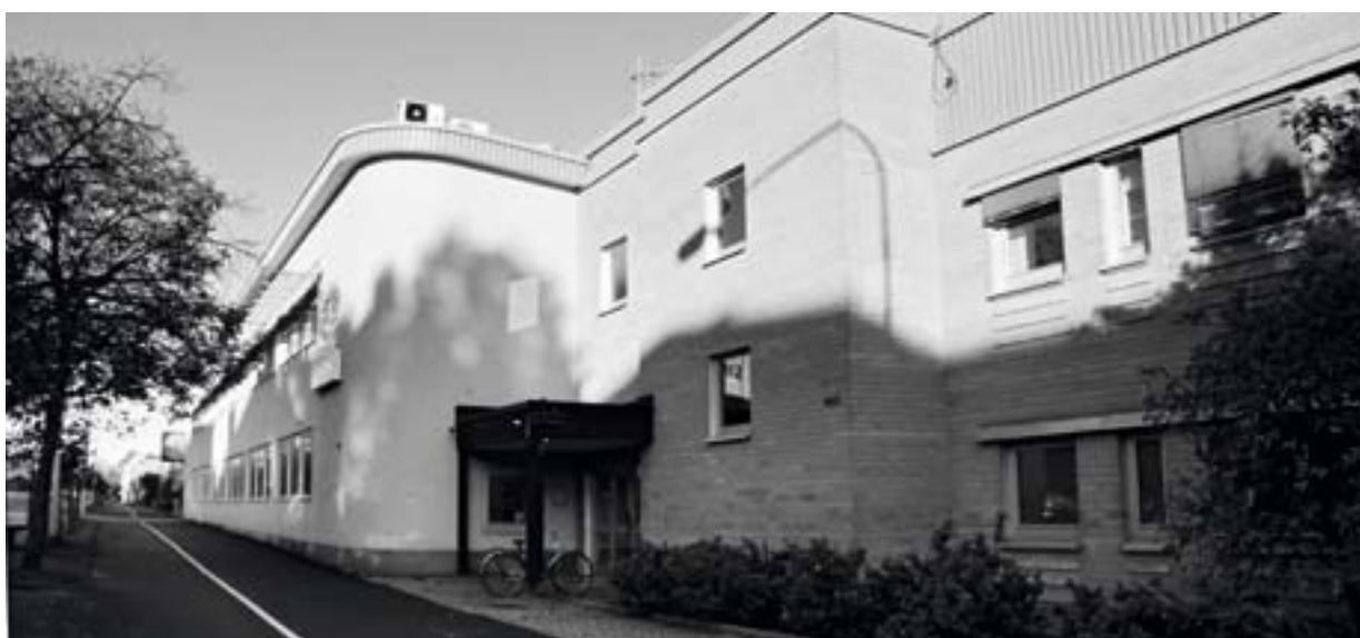
Norrköping Kabeln 1 – Klöver förvärvar i augusti fastigheten som består av 4 tkvm kontor.
